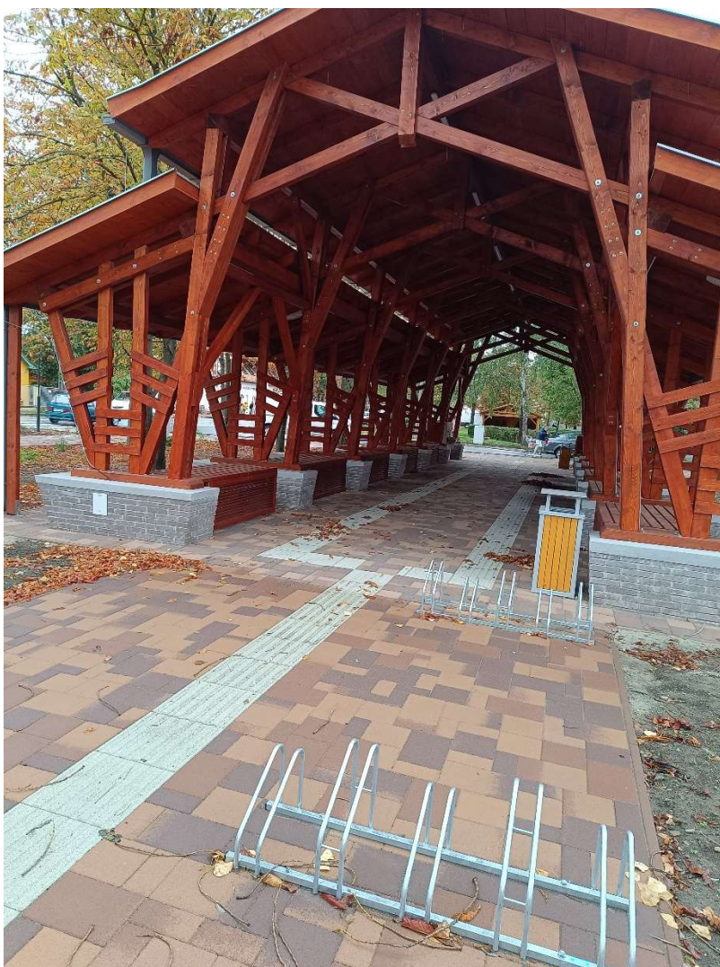
Térburkolat kerékpártárolóval, hulladék gyűjtővel
