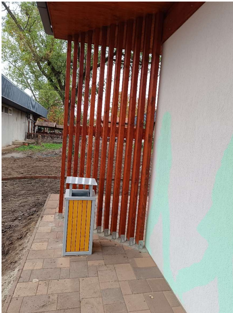
Vizesblokk, hulladékgyűjtő, térburkolat
