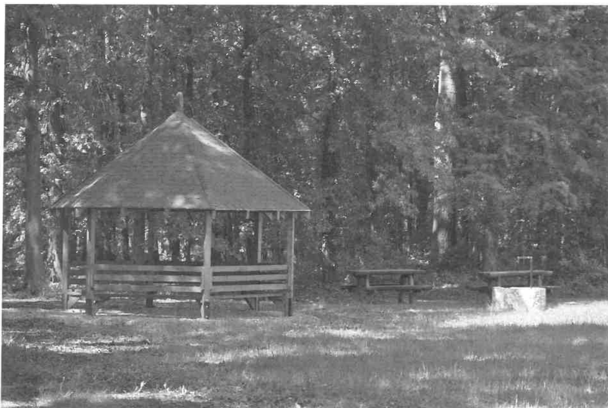
3.fotó: Esőbeálló aszfaltos padokkal
